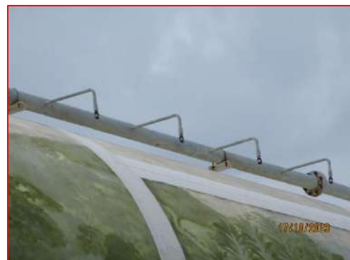
ภาพที่ 2-77 ระบบสปริงเกอร์น้ำ บริเวณพื้นที่ถังเก็บแอลพีจี
