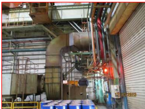
ภาพที่ 2-3 ระบบดักจับไอน้ำมันของปล่อย TM
