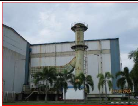
ภาพที่ 2-2 ระบบดักจับไอน้ำมันและปล่อย TCM
