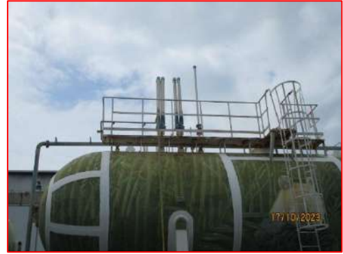
ภาพที่ 2-65 วาล์วป้องกัน (Safety Valve) ด้านบนถังแอลพีจี
