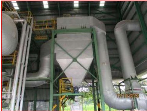
- ระบบดักฝุ่นแบบมัลติไซโคลน (Multi Cyclone)
