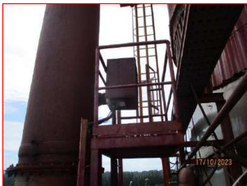
ภาพที่ 2-7 HCl Detector ติดตั้งไว้บริเวณปล่อย ARP
