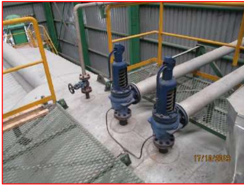
ภาพที่ 2-59 ติดตั้งลิ้นนิรภัยกับหน่วยผลิตไอน้ำ
