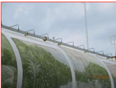
ภาพที่ 2-77 ระบบสปริงเกอร์น้ำ บริเวณพื้นที่ถังเก็บแอลพีจี
