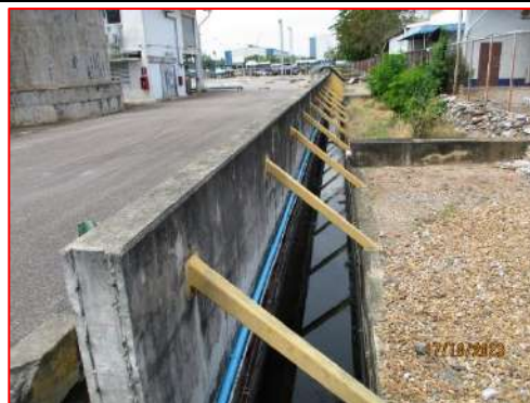
ภาพที่ 2-34 รางระบายน้ำฝน แยกออกจากระบบบำบัดน้ำเสีย
