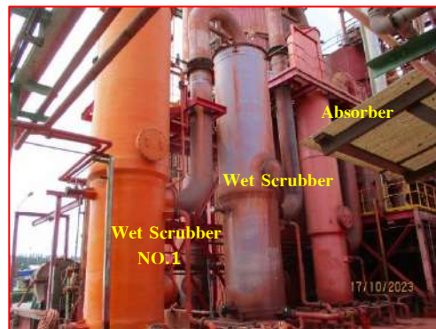
ภาพที่ 2-6 ระบบ Wet Scrubber และ Absorber ที่ปล่อย ARP
